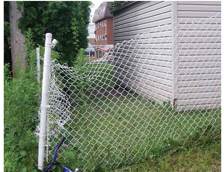
Clôture ayant subi un bris
