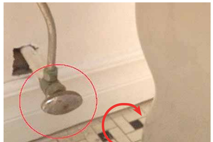
Valve de la toilette
